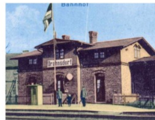
Der Bahnhof von Drahnisdorf
