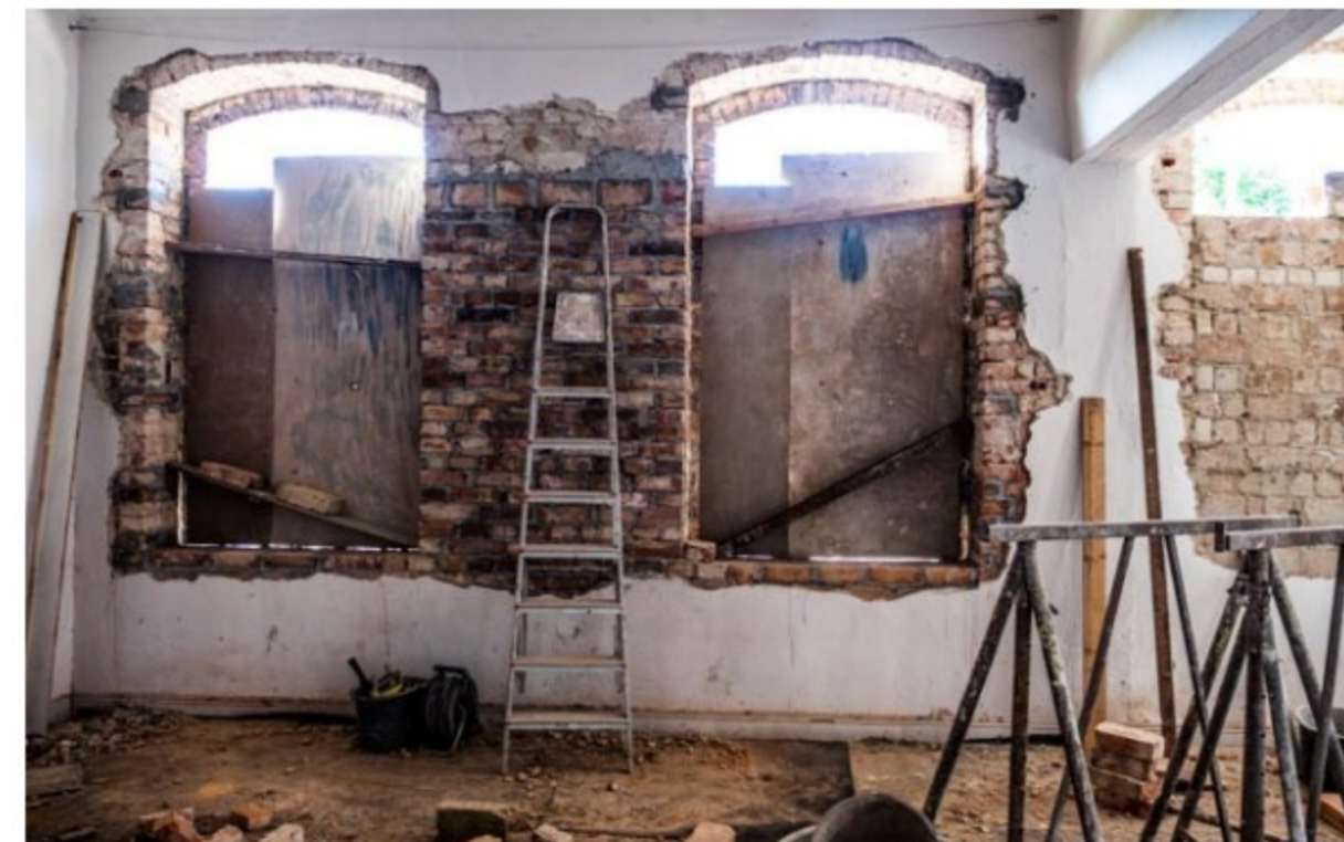
Rückbau der Fassade 2017
